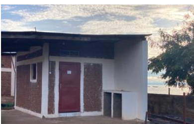
Poste de santé réhabilité de Mvugo
